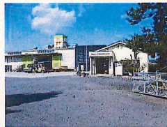
所在地 出雲市上場治町2775-5 会社概要 【昭和セメント工業株式会社】 薬種/コンクリート二次製品 設立年月日/昭和32年2月25日 従業員数/51人 【島根ライトコン工業株式会社】 薬種/建設業 設立年月日/昭和48年4月27日 従業員数/7人
