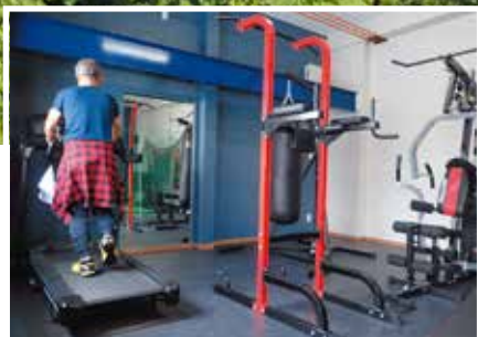
併設のトレーニングジムにはランニングマシン、筋トレマシンを設置
