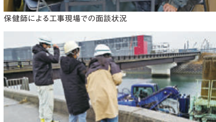
保健師による工事現場での面談状況
