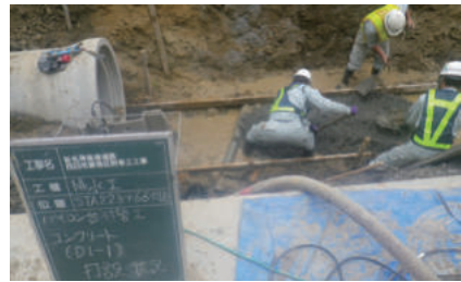
現場での施工状況
