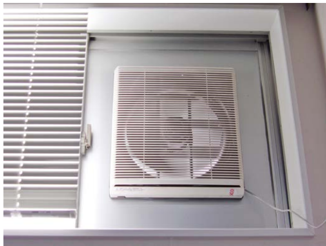
事務所、食堂、会議室への換気扇の設置
