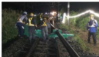
主に深夜に行われる、鉄道線路保守作業
