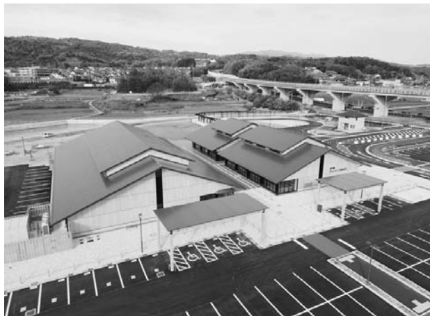
森村設備が設備工事を担当した「道の駅 クロスウェイなかまち」
