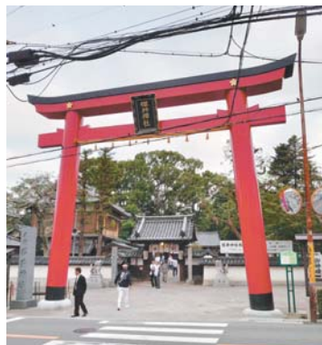
製作から設置まで行った 高さ12mの鋼製大鳥居
