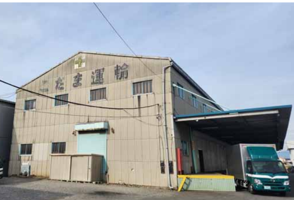
物流倉庫とトラックヤード
